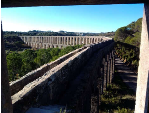
Aqueduto dos Pegões-Tomar
